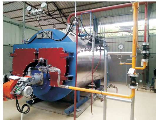
2017.01-7MW WNS7-1.0/95/70-Q 安徽亳州华佗国际中药城有限公司
